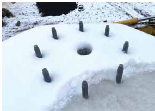
Монтаж мачт освещения
