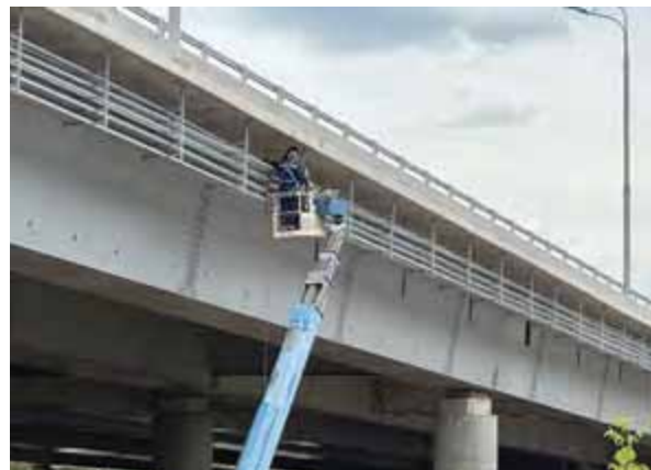
Монтаж кабеленесущих систем
