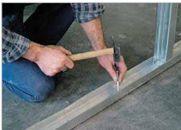
Монтаж профиля для гипсокартона
