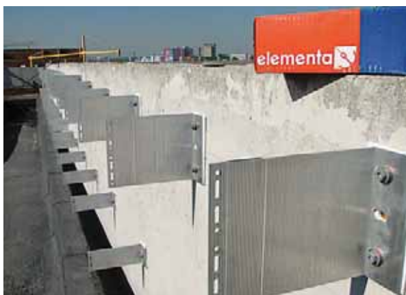
Монтаж кронштейнов НФС
