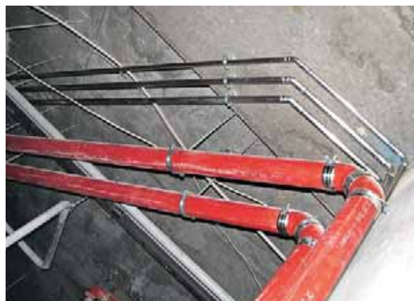
Монтаж тяжелых инженерных систем
