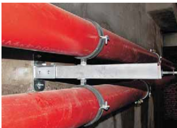
Монтаж инженерных систем
