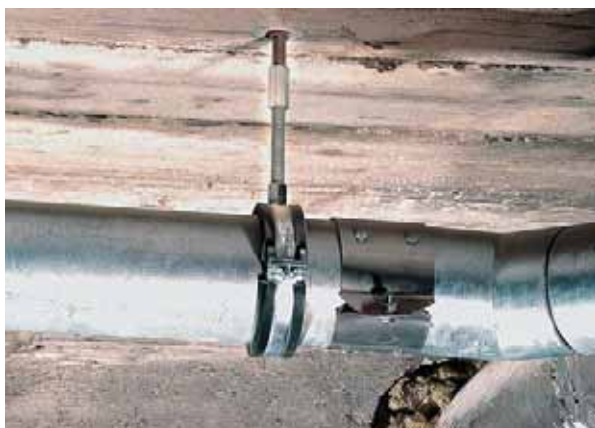
Монтаж тяжелых инженерных систем
