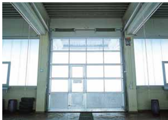
Монтаж автоматических ворот
