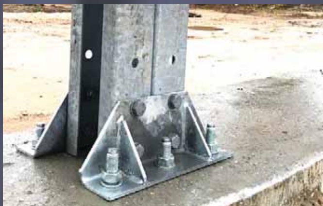
МОНТАЖ БАРЬЕРНЫХ ОГРАЖДЕНИЙ
