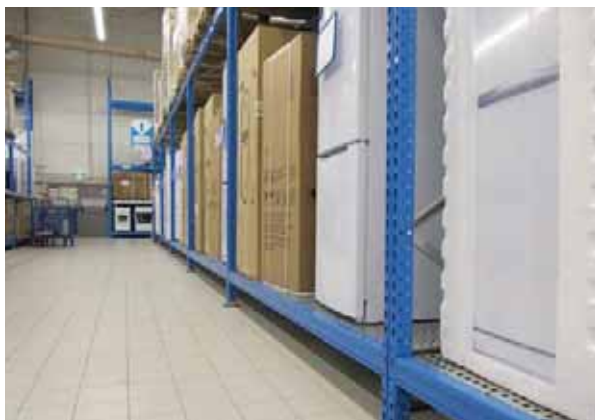
Монтаж складского оборудования
