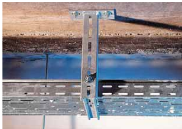
Монтаж инженерных систем
