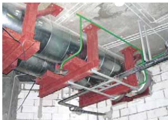
Монтаж систем вентиляции
