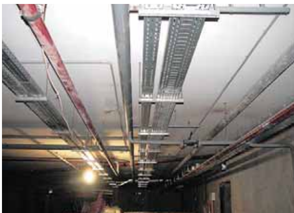
Монтаж инженерных систем
