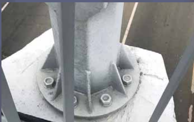
МОНТАЖ КОНСТРУКЦИЙ В РАСТЯНУТЮ ЗОНУ БЕТОНА
