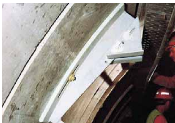
Монтаж тоннельных коммуникаций
