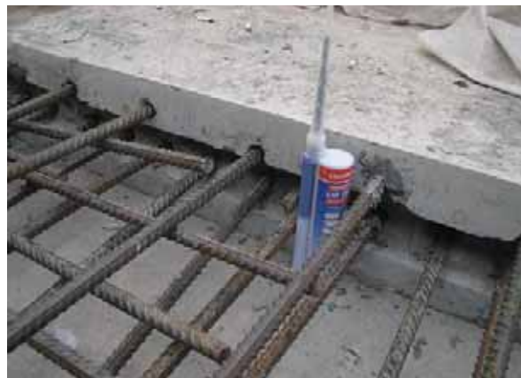
Монтаж арматурных выпусков
