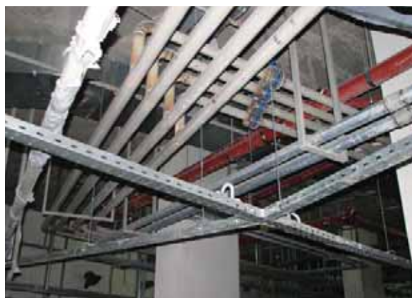
Монтаж инженерных систем
