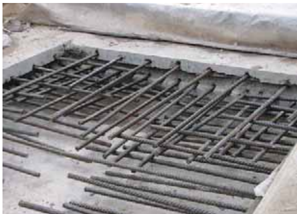
Монтаж арматурных выпусков
