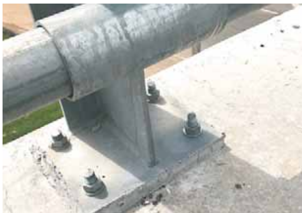
Монтаж дорожных ограждений
