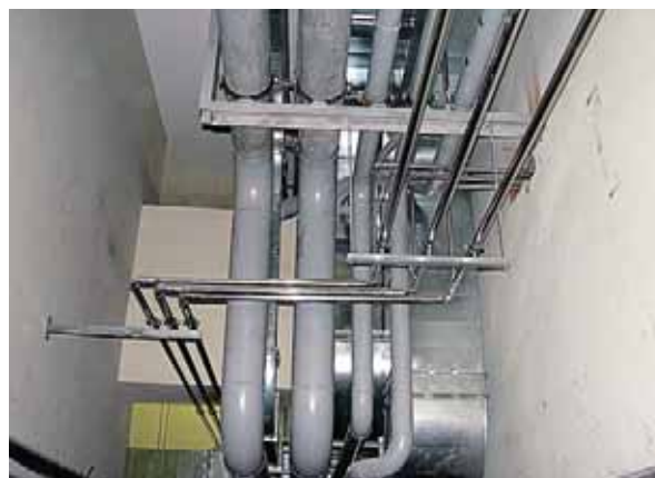
Монтаж инженерных систем
