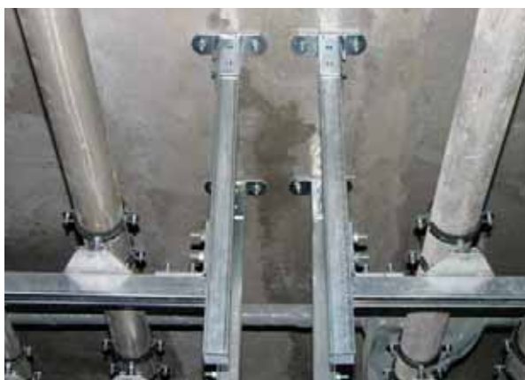
Монтаж инженерных систем
