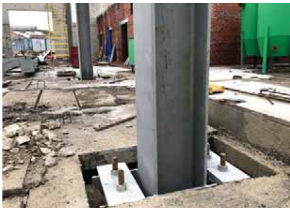
Монтаж стальных колонн
