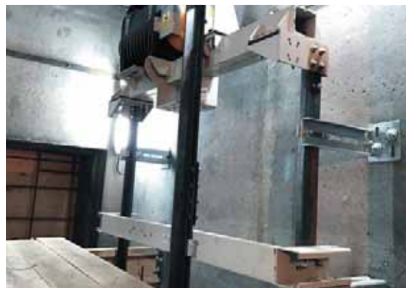
Монтаж лифтовых направляющих
