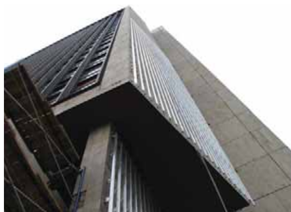
Монтаж кронштейнов НФС
