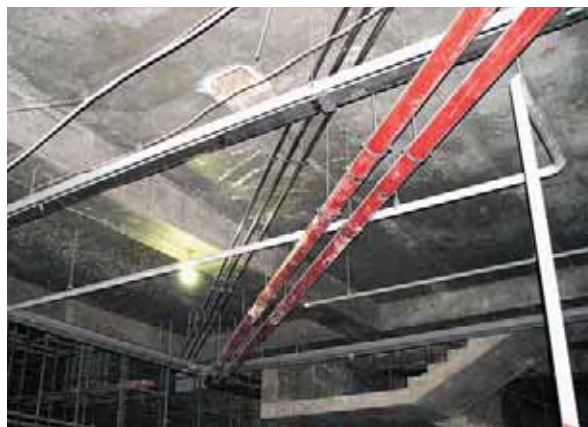
Монтаж инженерных систем
