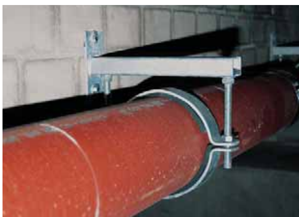
Монтаж инженерных систем
