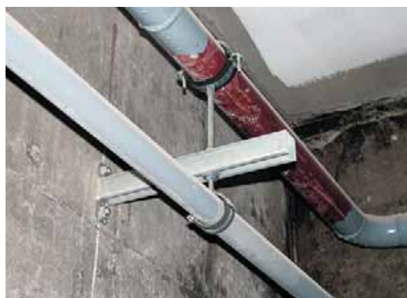
Монтаж инженерных систем
