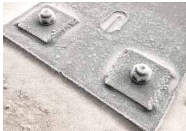
Монтаж витражных конструкций
