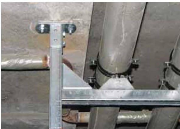
Монтаж инженерных систем
