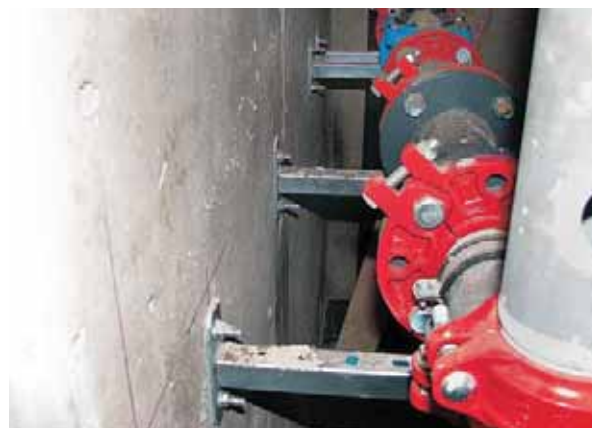
Монтаж инженерных систем
