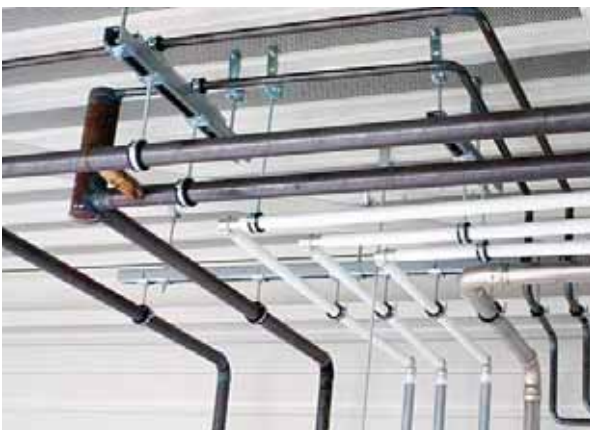
Монтаж инженерных систем к профнастилу
