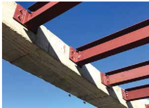
Монтаж стальных балок
