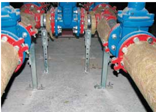
Монтаж инженерных систем
