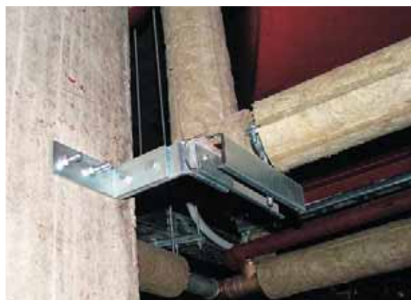
Монтаж инженерных систем
