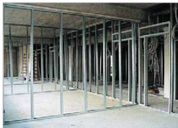
Монтаж профиля для внутренних перегородок
