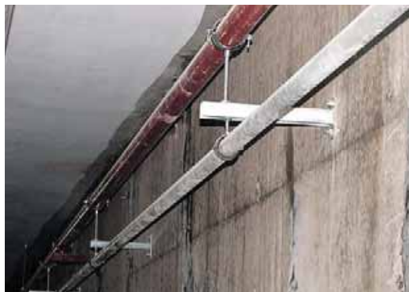
Монтаж инженерных систем
