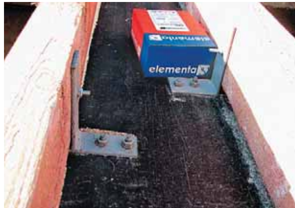
Монтаж стропильных балок
