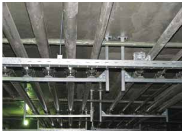
Монтаж инженерных систем
