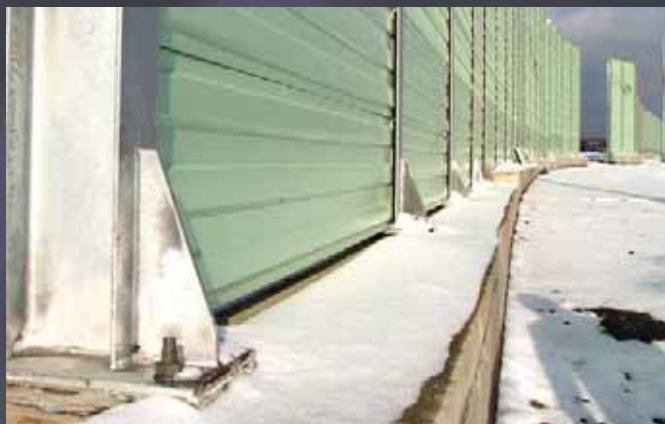
МОНТАЖ ШУМОЗАЩИТНЫХ ЭКРАНОВ
