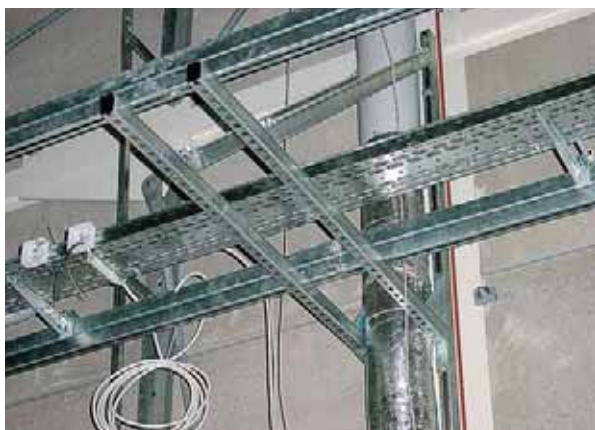
Монтаж инженерных систем
